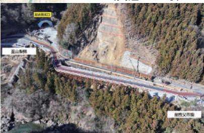
大滝トンネル起点側からドローン写真(R7.1撮影)
