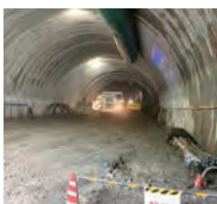
発破によって生じた土砂をすくって運搬する「ずり出し」の様子。
